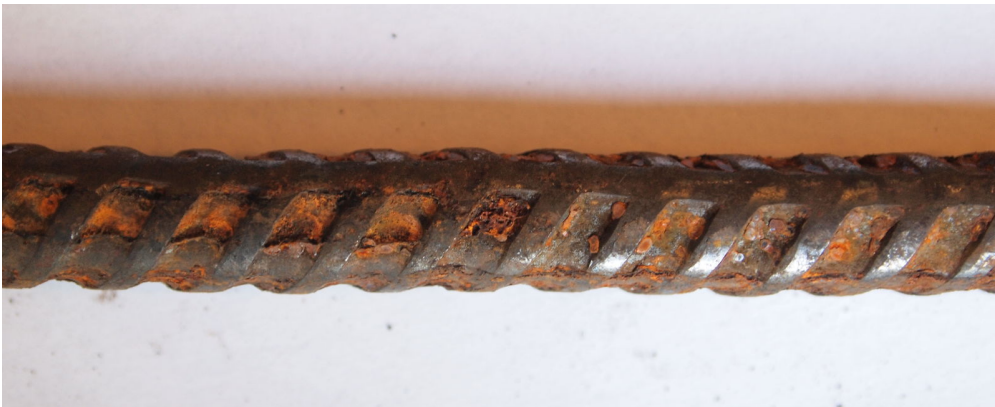
Figur F.1: Armeringsstålet før det blev støbt ind i mørtlen. Kan bruges som reference til de visuelle undersøgelser.
