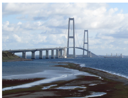
(b) Storebæltsforbindelsens østbro. Pylonerne og bropillerne er af beton. Kablet og brodrageren er af stål
