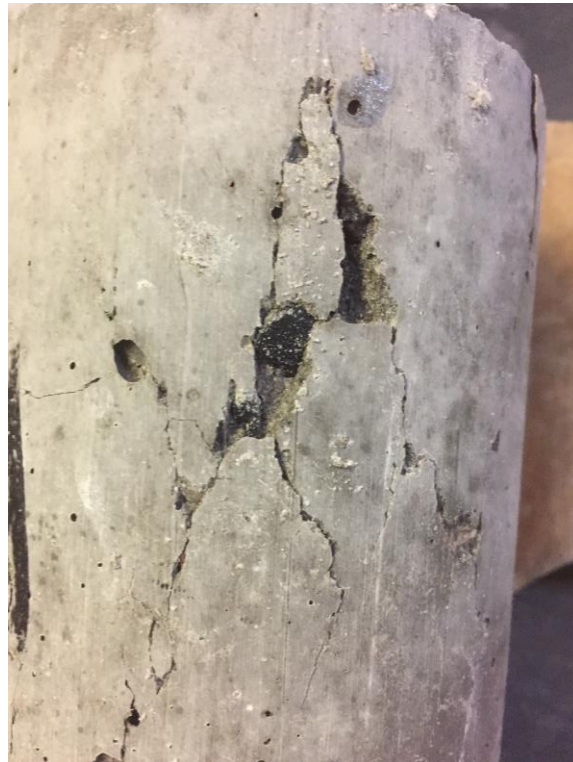
Figur 35 - Illustration af brud ved asfalts stykke
